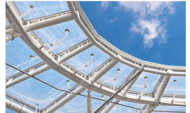
‘클라우드’에 사용된 ETFE(Ethylene Tetra fluoro Ethylene)는 열가소성 불소수지 소재로 매우 가볍고, 유연하고, 일광 투사율이 높으며 내구성이 탁월하여 식물원, 아케이드 등의 건축물에 유리 대용으로 많이 쓰이고 있다.
